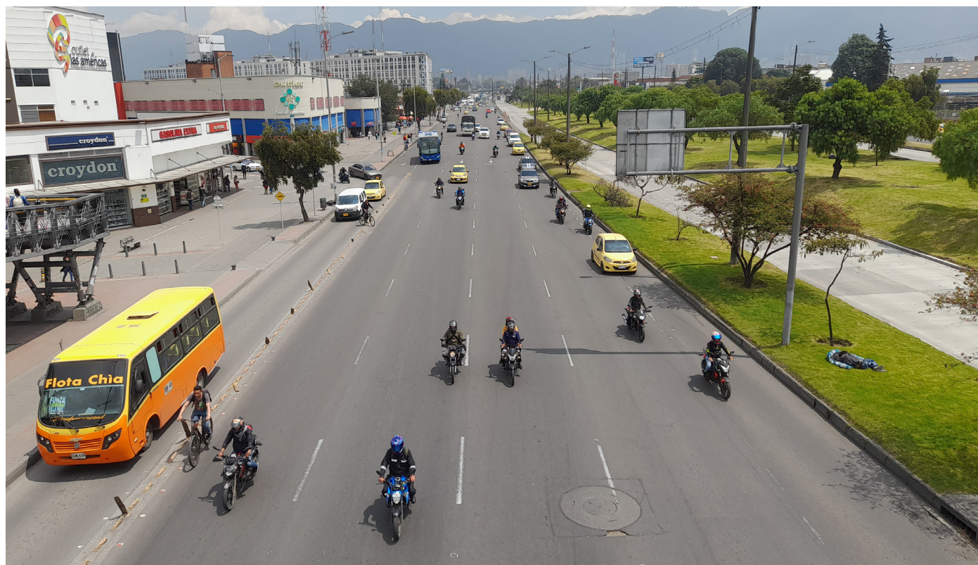
FIGURA 15 | Una vía ancha en Bogotá, Colombia, con incorporaciones bruscas y sin control, y varios carriles que conducen a múltiples puntos de conflicto
