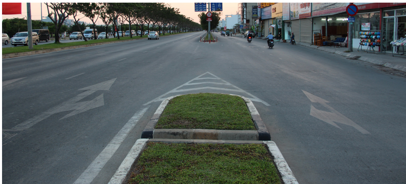
FIGURA 14 | Punto de acceso no controlado en un separador en Ciudad Ho Chi Minh, Vietnam, que permite la incorporación en ambos sentidos en una distancia corta. Estas aberturas son lugares de alto riesgo para los motociclistas
