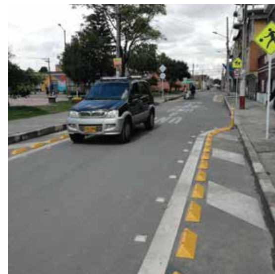
Figura 10.10 | Materiales de mediano plazo instalados en Tunjuelito para formar un angostamiento luego del éxito del proyecto piloto temporal
