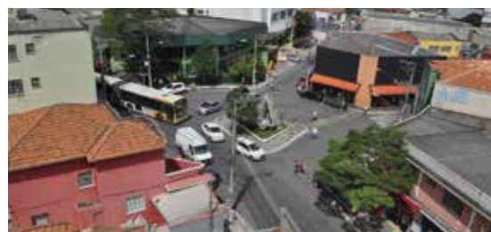
Figura 10.3 | Antes de la intervención emergente
