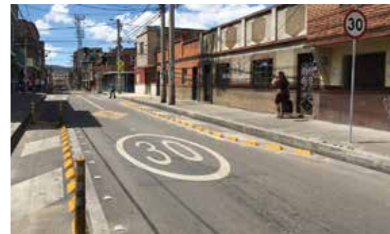
Figura 10.12 | Materiales de mediano plazo instalados en Tunjuelito para formar un angostamiento luego del éxito del proyecto piloto temporal
