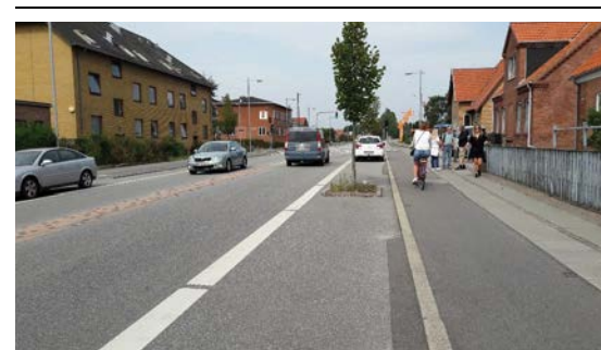
Figura 10 | En Nykøbing F, Dinamarca, hay un carril para ciclistas junto a la acera y separado del carril para vehículos por un carril de estacionamiento y un bordillo
