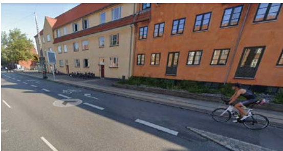
Figura 28 | Finalización de una zona de transición de carril para ciclistas, que permite que los ciclistas y el tráfico motorizado que gira se mezclen antes de la intersección, Dinamarca
