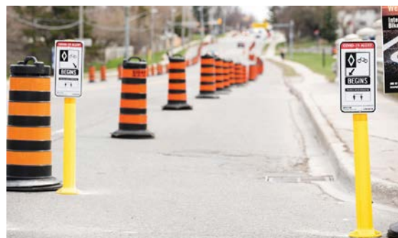
Figura 19 | La separación vertical temporal creada por barriles de plástico protege a los ciclistas de lesiones si golpean la barrera (Brampton, Ontario)
