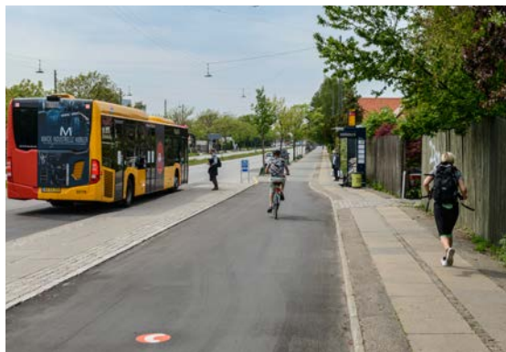
Figura 36 | Pista permanente para ciclistas con parada de autobús y estacionamiento en una autopista para ciclistas en Copenhague
