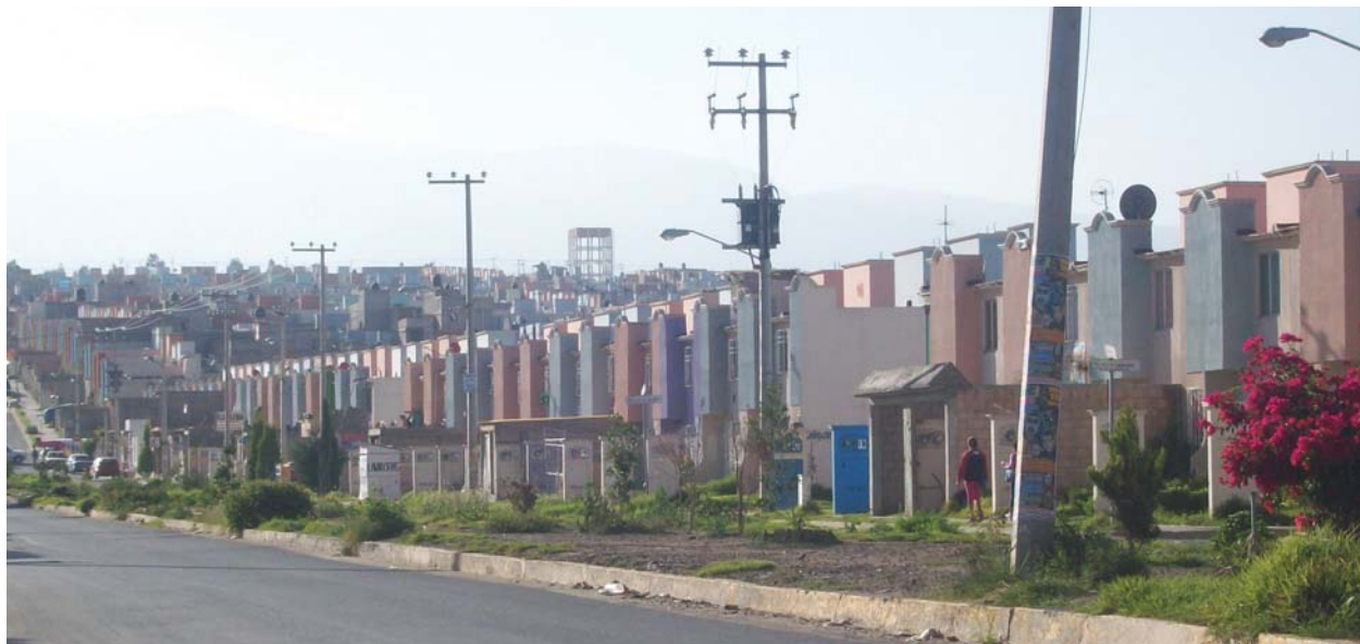
Hacienda Chicoloapan, una nueva unidad habitacional a los pies de la autopista; sin servicios o espacios públicos de calidad.
